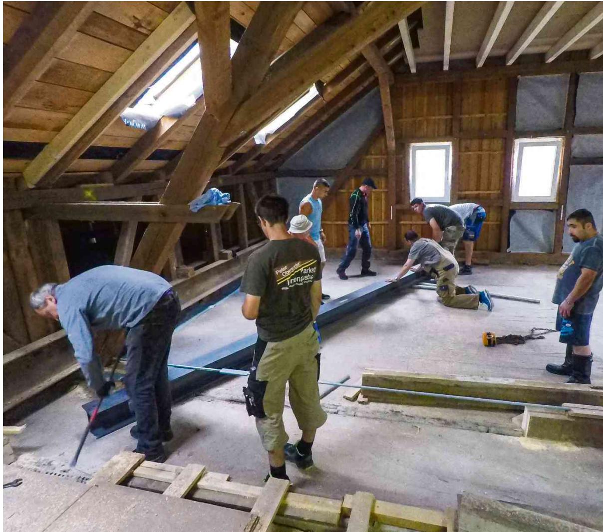
Unzählige Stunden freiwilliger Arbeit wurden hier geleistet: die Bauarbeiten auf dem Dachboden des Feuerwehrdepots in ihren Anfängen. Fotos: privat
