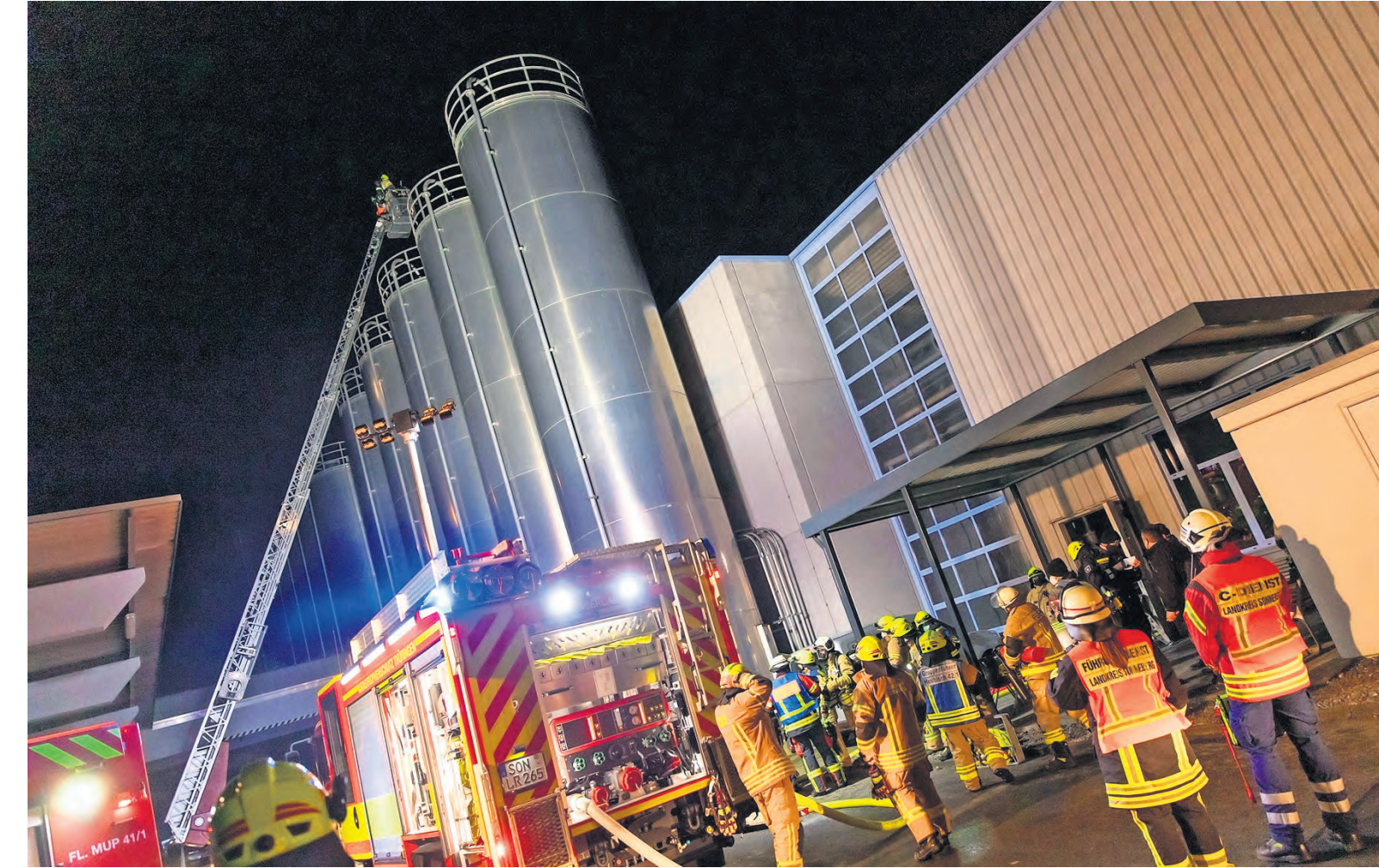
Auf einem Betriebsgelände im Ortsteil Rohof kann es am Montagabend gegen 21.30 Uhr zum Brand eines Hochspannungs-Transformators. Foto: Steffen Ittig
