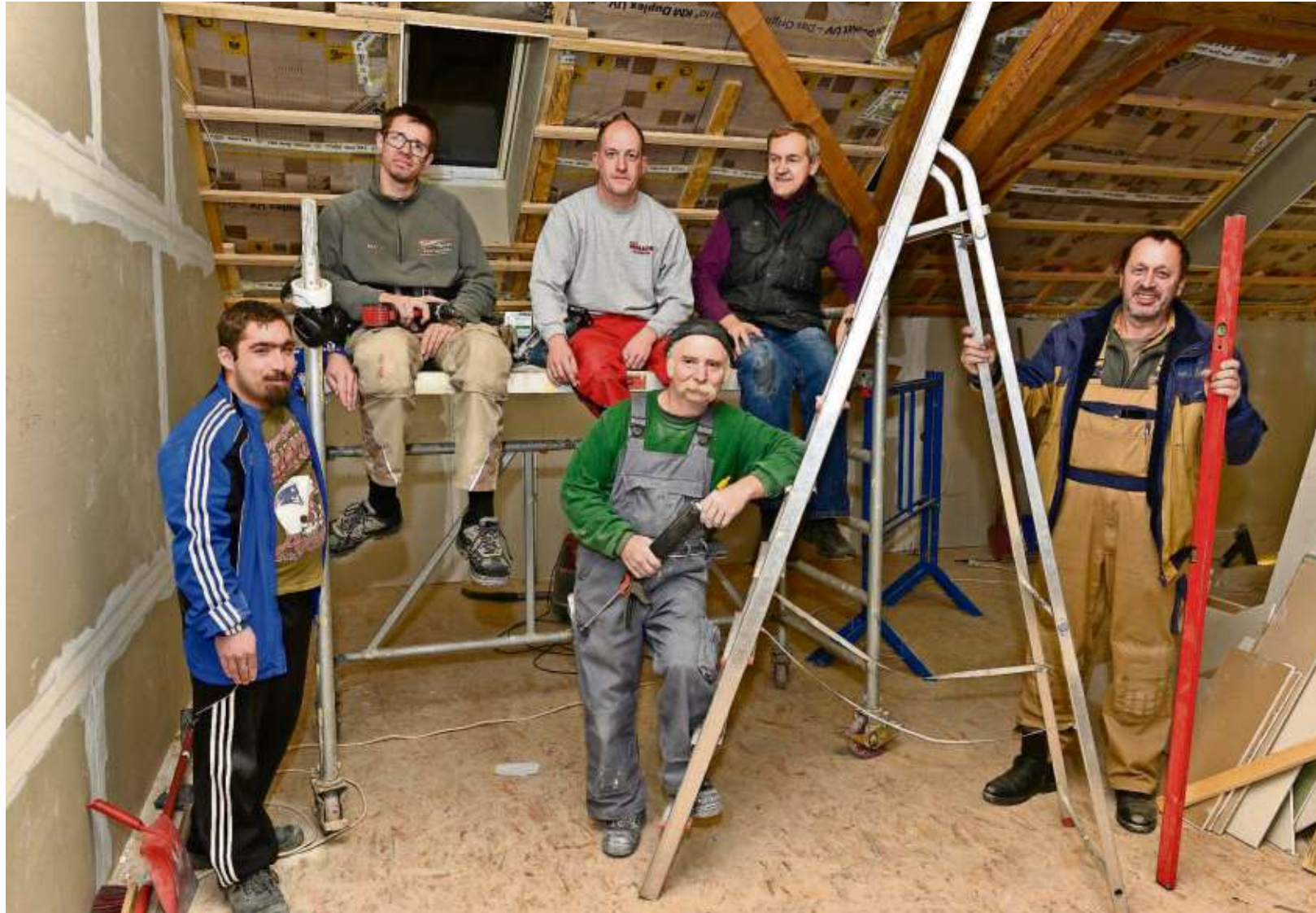
Ein Teil des Teams, das sich um den Ausbau des Dachgeschosses am Feuerwehrgerätehaus in Heubisch kümmert.
